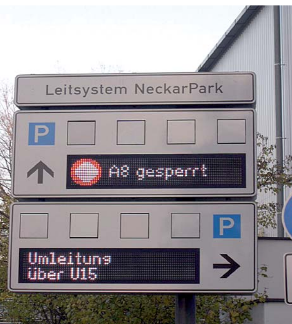
System parkowania i wskazywania drogi w NeckarPark (PVLS)
