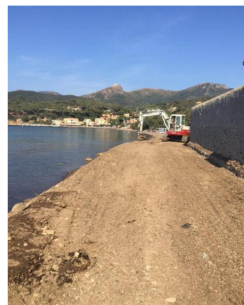
Figure 21: Portoferraio: Historic “Cammin di Rada” Accessibility
